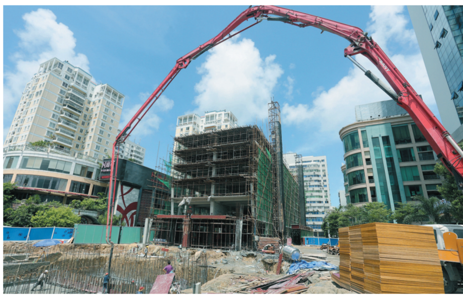
6月30日上午，市政府二办立体停车楼工地，一辆大型工程车正在进行浇筑施工。
